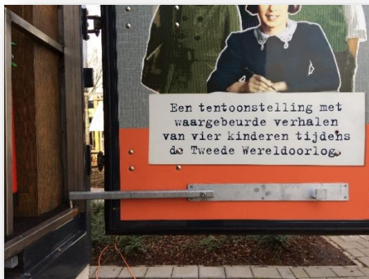
De deuren worden vergrendeld met de omslaande balken
