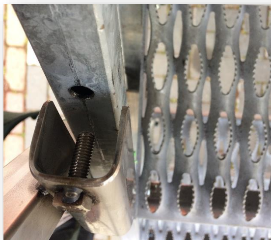
De moer bevindt zich aan de bovenzijde van de leuning
